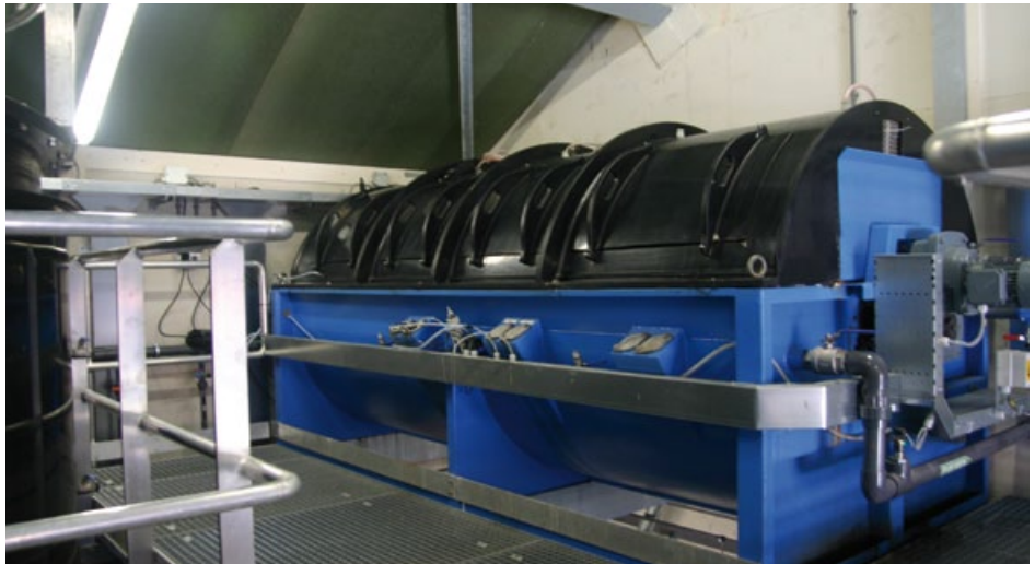
Biorotor, haalt stikstof uit zwart afvalwater.
